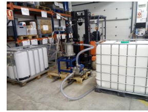
Planta piloto en Lurederra pruebas escala semi-industrial
